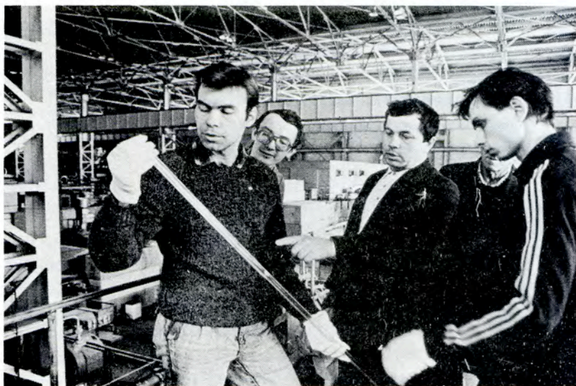
Испытание экструзионного устройства для изготовления сцинтилляторов методом вытяжки расплавленной массы
