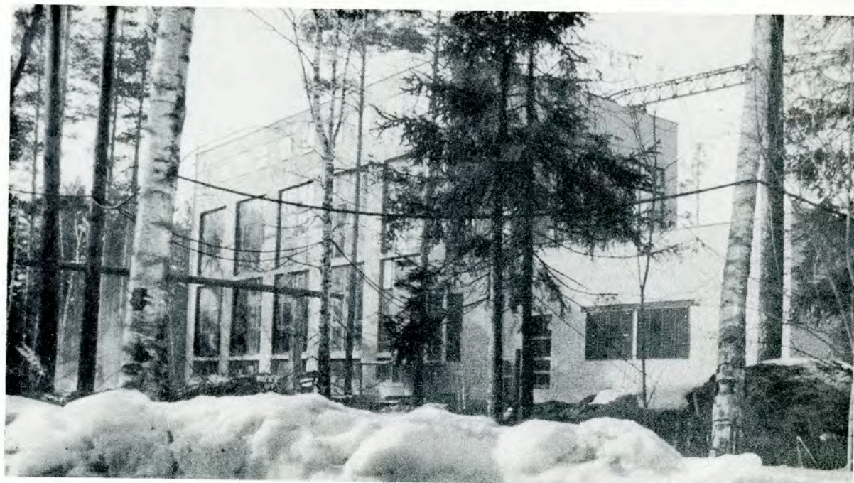
Рис. 68. Строительство нового корпуса для испытания пузырьковых камер и других криогенных работ.
