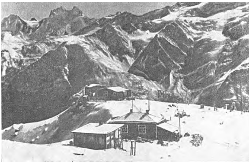
Верхняя часть геофизической станции «Пик Терскол». Несколько ниже, справа снимка находится 30-тиметровая оптическая вышка. Все это заново построил Федоров Е.К.
