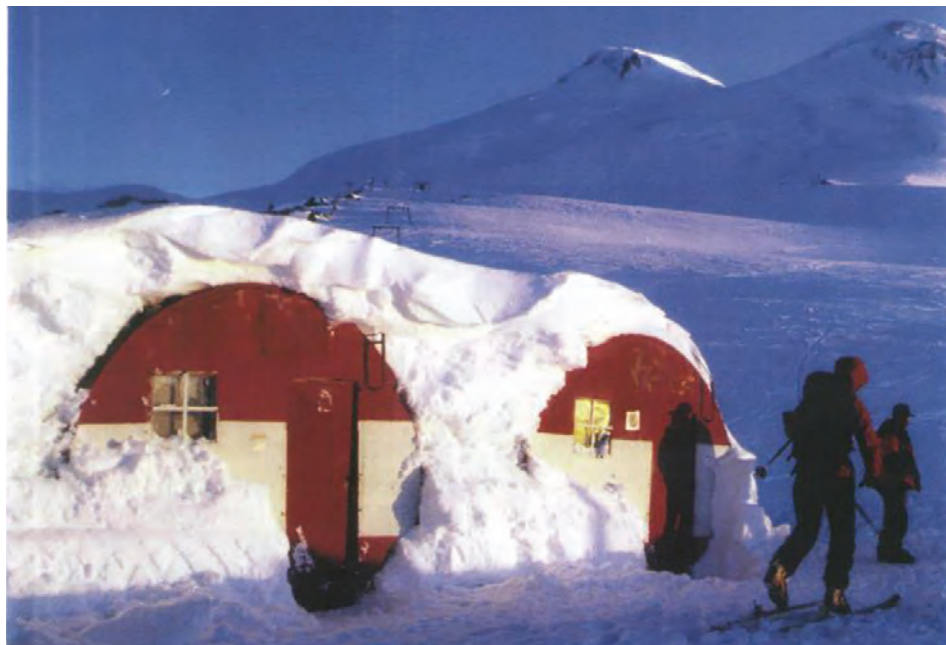
Фото 6. Ошибка строителей дороги обходится жильцам этих домиков: после каждого снегопада и метели горнолыжникам, живущим в этих сигарообразных домиках на склонах Эльбруса, приходится тратить значительные силы и время на расчистку от снега входов в эти жилища
