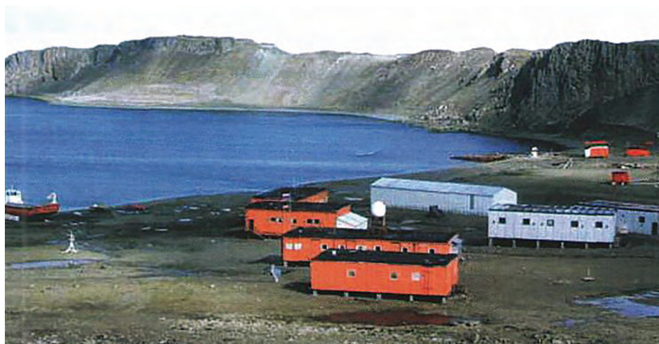
Фото 7. Уже давно специалисты нашли пути борьбы со снежными заносами своих строений в Арктике и Антарктике, да и в горах: для этого нужно строение устанавливать на сваях на 1–1,5 м выше над поверхностью земли; на снимке — станция Беллинсгаузена в Антарктике; из снимка видно, что все строения последних лет стоят на сваях
