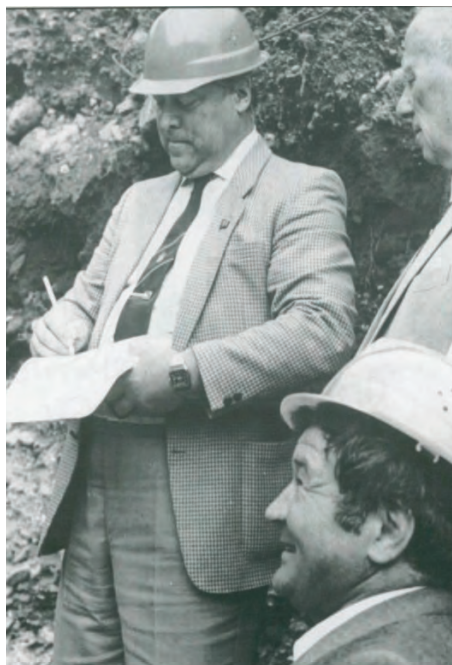
Председатель Госкомгидромета СССР Ю. Израэль, директор ВГИ М. Залиханов и секретарь парткома ВГИ С. Андреев на закладке первого камня нового лабораторного корпуса ВГИ в Нальчике
