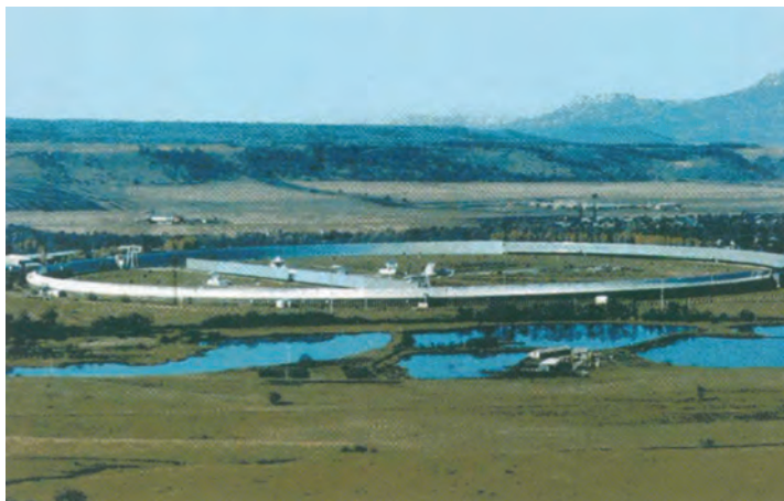
Современный круг. РАТАН-600 — радиотелескоп с 600-метровой кольцевой антенной
