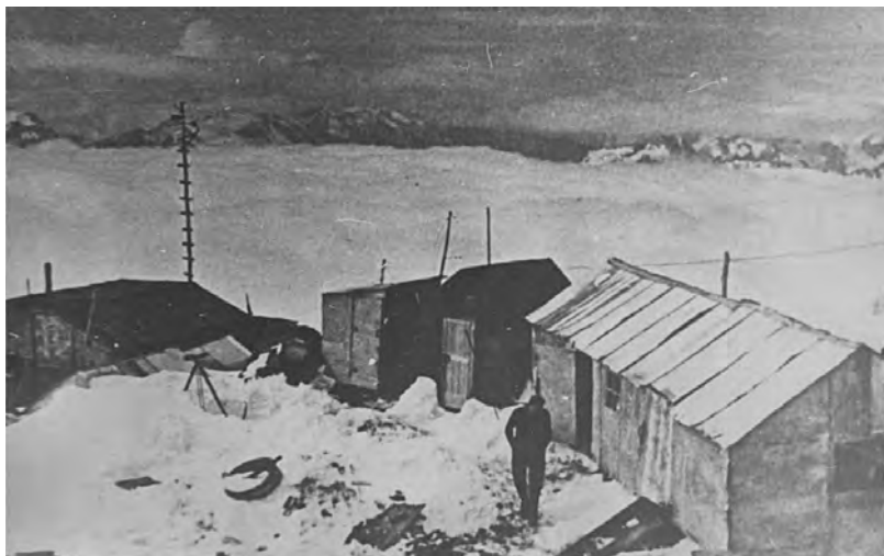
Общий вид построен на «Кругозоре». Слева — хижина (Приют)
