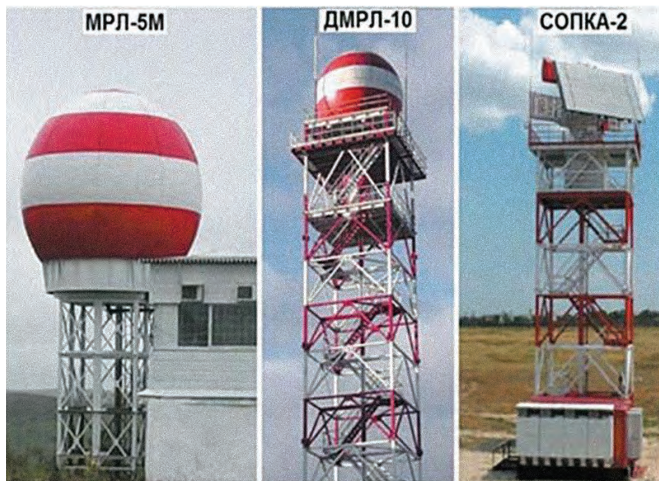
Радиолокаторы с программой автоматизации противоградовых операций
