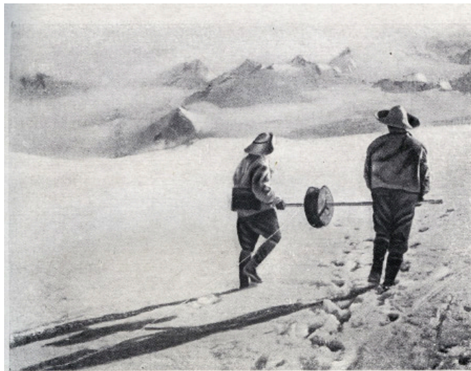
Прокладка телефонного кабеля на высоте 4000 м.—Laying telephone cable at an altitude of 4000 m.
