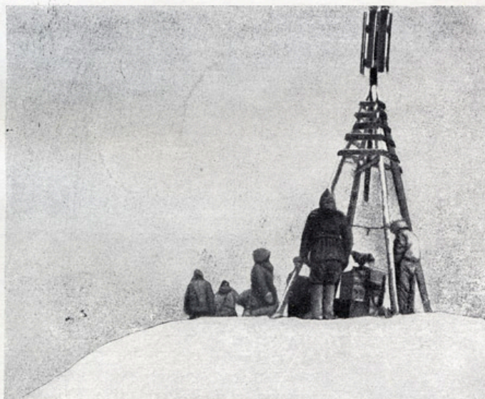
Высшая точка Европы—западная вершина Эльбруса (5640 м). Геодезисты устанавливают триангуляционный пункт.—The highest point in Europe—the west peak of the Elbrus (5640 m). Geodesists fixing the triangulation station.
