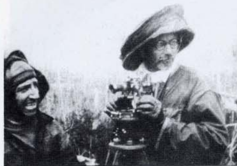
Советский геолог Л. А. Кулик (справа) и его помощник в 1930 г. изучают место Тунгусского события 1908 г. в Восточной Сибири. Кулик, одетый в накомарник, настраивает теодолит.
